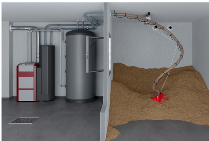
Technikraum inklusive Pufferspeicher und Pelletbunker.
